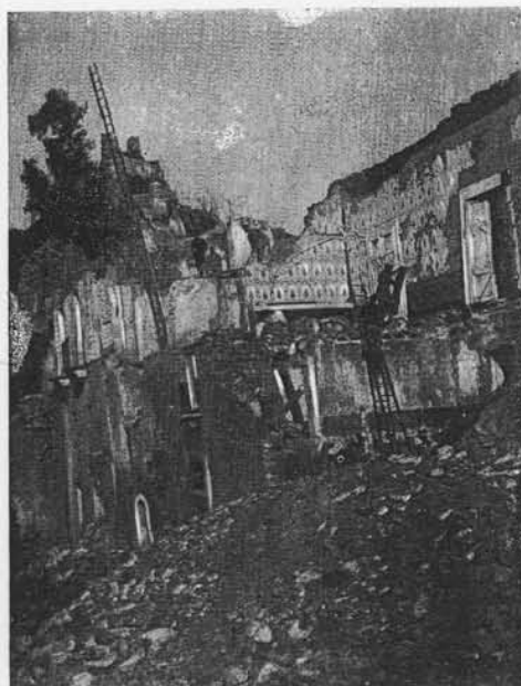
Palazzo Belmonte dopo le demolizioni.
