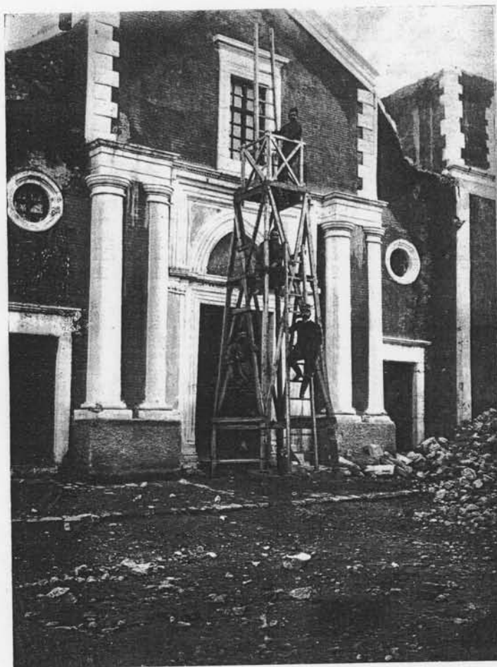
Castello costruito e lasciato in Aiello
